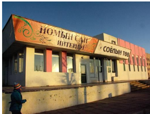
バガノール区 カルチャーセンター
